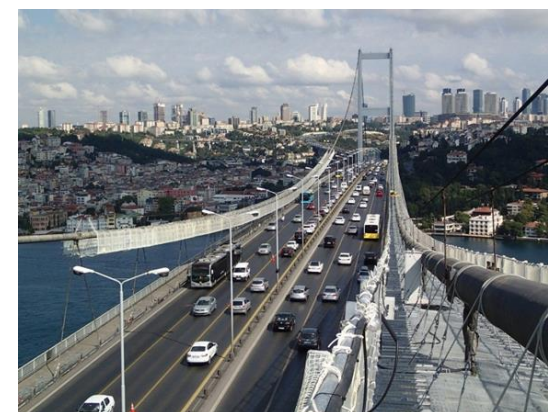
第1ボスポラス橋補修工事
