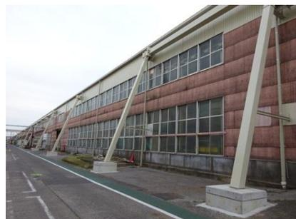
アウトフレーム式 耐震補強
