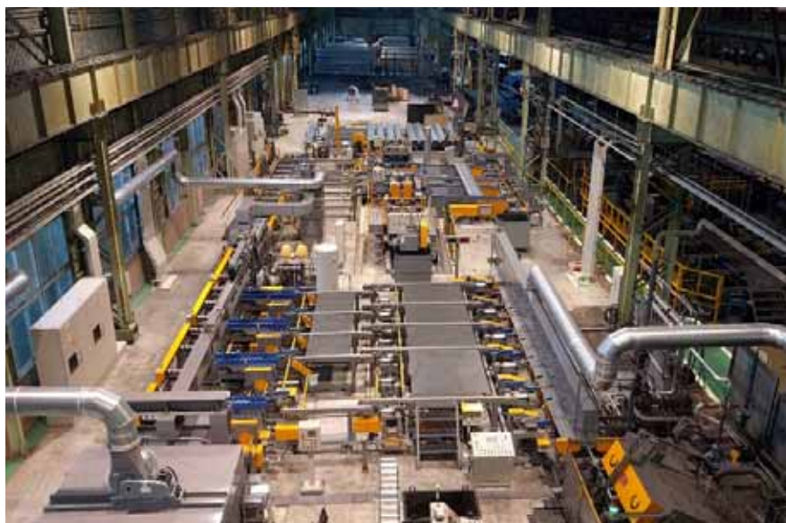
東京工場 1号機
