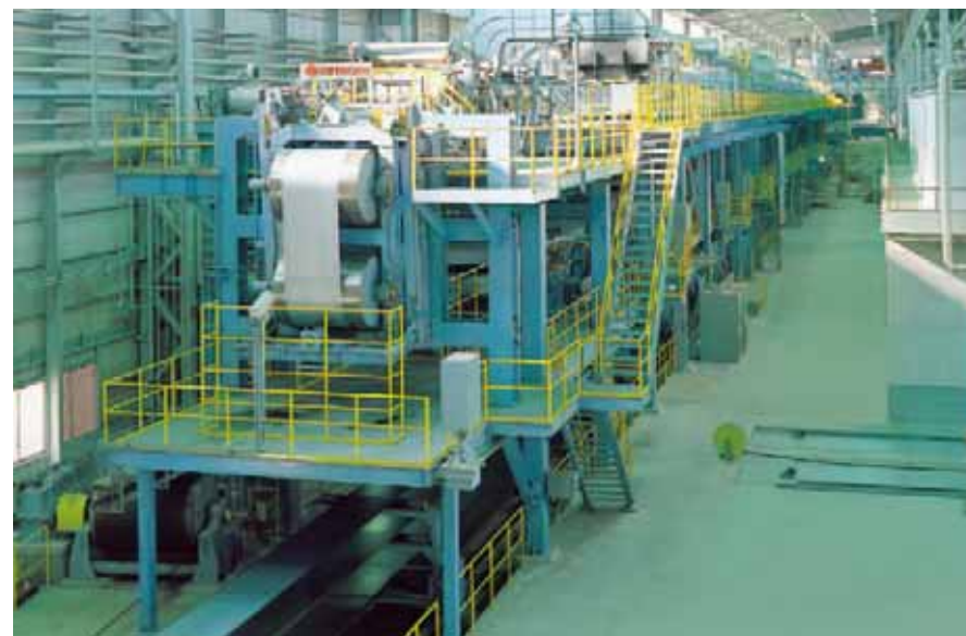
詫間工場 めっきライン(1989年設置) リニューアル予定
