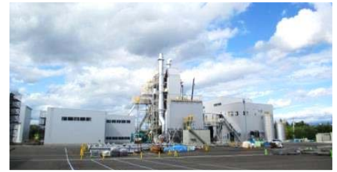
※花巻バイオマスエナジープラント設置工事(H28/9/9撮影)
