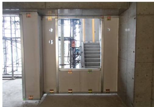
「ALC金物無溶接工法」で施工した共用廊下側の外壁
