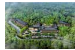
2017.3開業予定 湯河原離宮 (187室)
