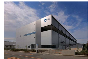
ロジスクエア久喜新築工事(埼玉県)
