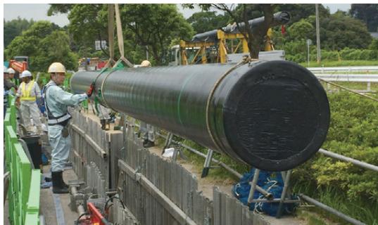
建設が進む 九州北部幹線 (2020年完成予定)
