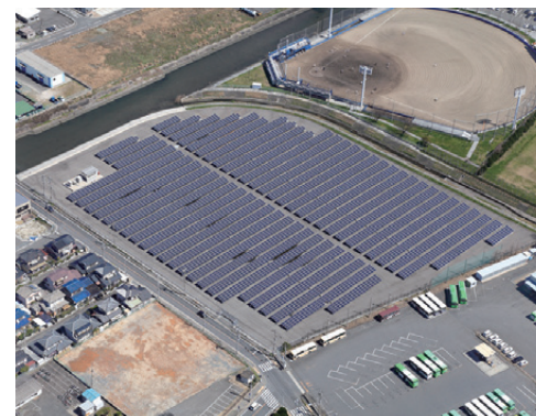
エネ・シード響南太陽光発電所
