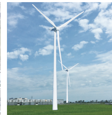
エネ・シード北九州風力発電所 (2017年3月運用開始予定)
