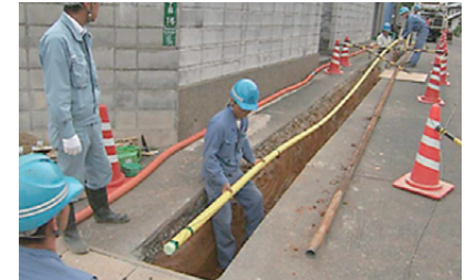
耐震性の高いポリエチレン管への取り替え
