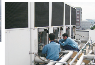
ガス空調(GHP)のメンテナンス作業
