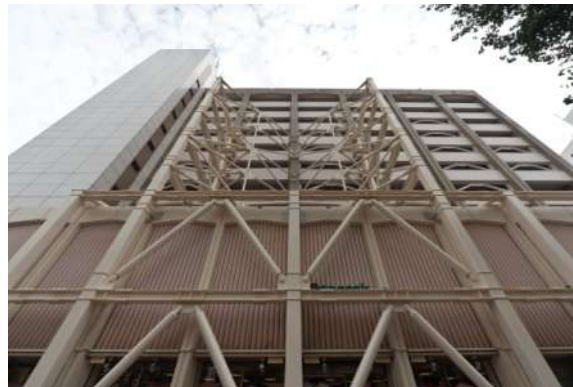
マンション耐震補強工事の施工事例
