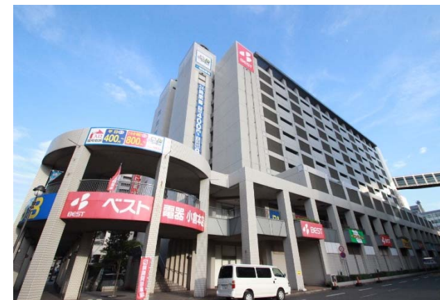
約1,000台の立体自走式駐車場
