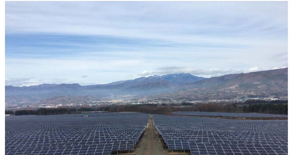
いちご昭和村生越ECO発電所(関東最大級)
