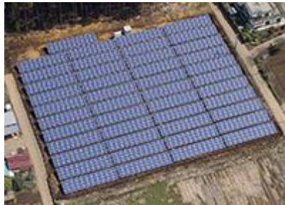
S-03 LS千葉若葉区発電所
