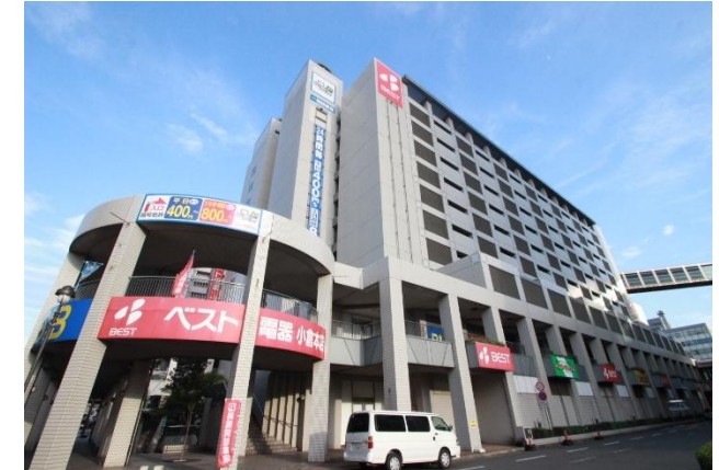
約1,000台の立体自走式駐車場
