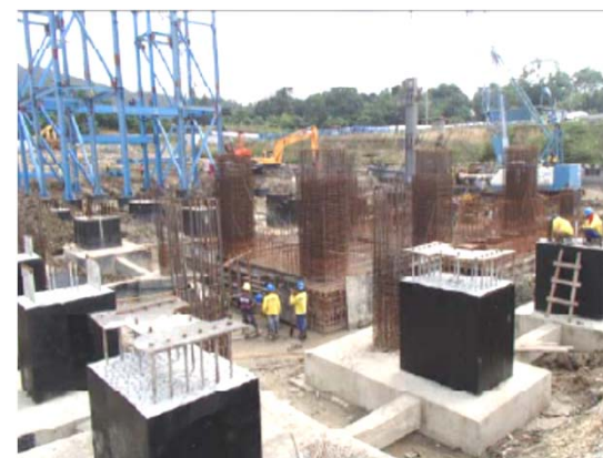
タービン・発電機建屋基礎
