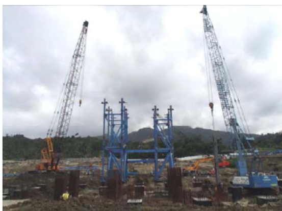
ボイラー鉄骨の組立
