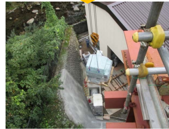
機器(重量物)搬入状況
