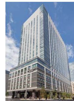
京橋トラスタワー コートヤード・バイ・ マリオット 東京ステーション
