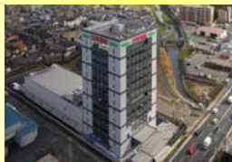
本社ANNEX グローバル研修センター
