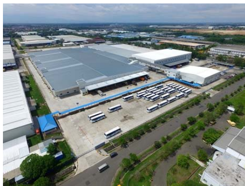
インドネシアエプソン新工場
