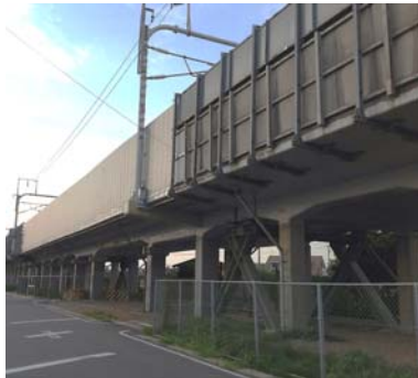
大規模改修工事(コンクリート橋)
