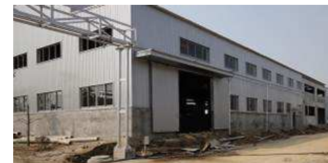
↑ 建設中の様子
