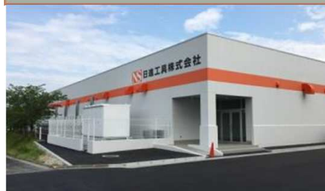
新工場棟（E棟）
