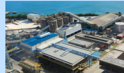
排熱発電設備
