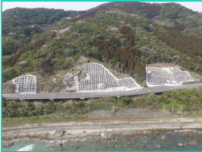
宮崎関内道路防災工事 （法面保護工事）
