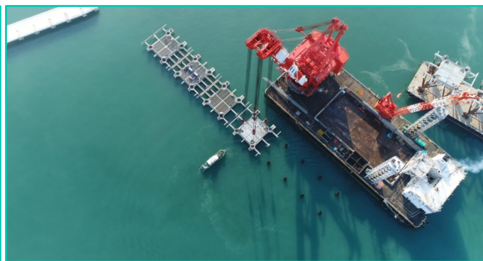
釧路港西港区-14m岸壁B部上部建設工事
