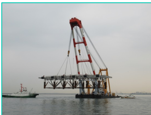
博多港(中央ふ頭地区)岸壁改良工事
