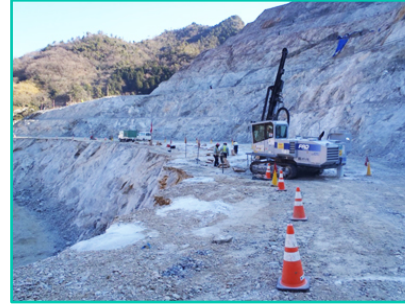
大分川ダム建設工事 （爆砕工事）
