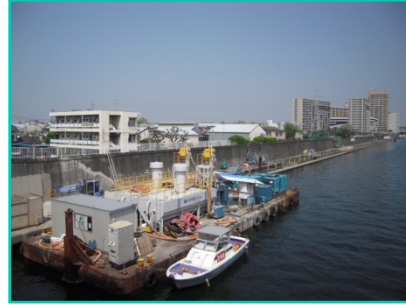
隅田川防潮堤耐震補強工事 （地盤改良工事）
