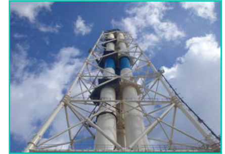
火力発電所煙突内部ライニング工事 （耐火工事）
