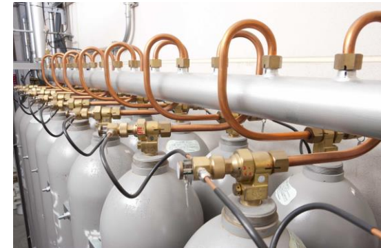
ガス系消火設備 容器弁
