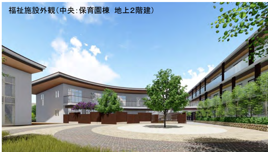
福祉施設外観(シニア棟 地上3階建)
