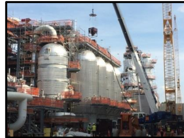
脱水装置への吸湿剤充填
