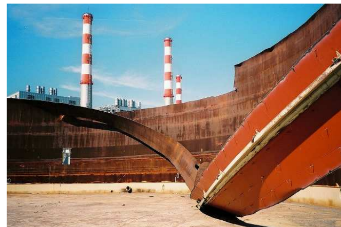
火力発電所（リンゴ皮むき工法）
