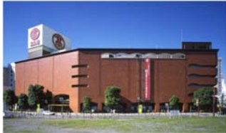
【高崎】9月全館改装 駅と高架橋で接続
