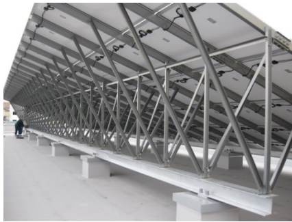
①太陽電池アレイ支持架台
