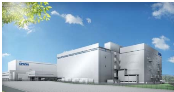
広丘事業所 インクジェットプリントヘッド 生産・開発機能強化（建設中）
