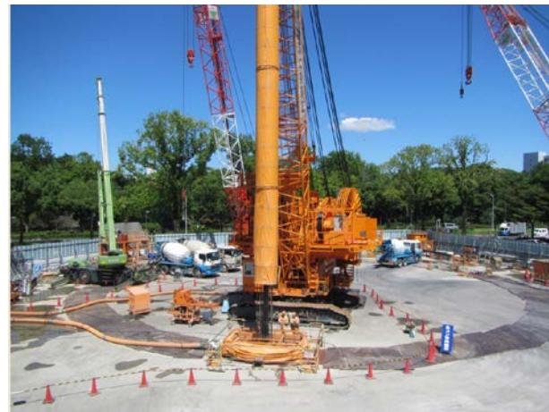
名城非常口 (地中連続壁工)
