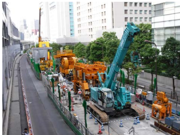
品川駅 (地下駅の地中連続壁工)
