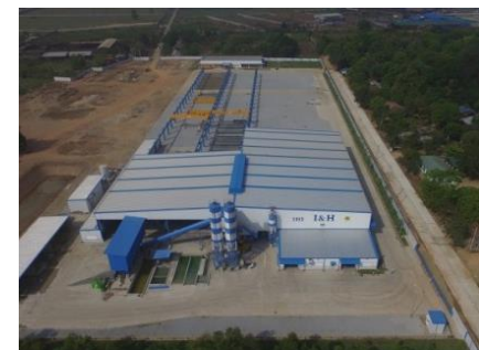
ミャンマー コンクリート製品工場 (2017年4月稼働)
