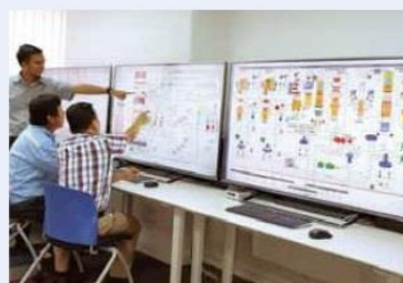
マレーシア現地法人 運転監視・支援センター (ボイラ)
