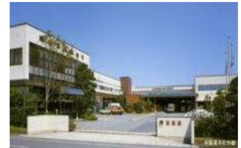
寿製菓(株) 本社工場
