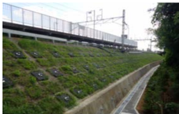
耐震補強後の盛土区間
