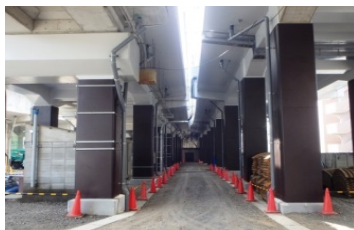
耐震補強後の高架橋
