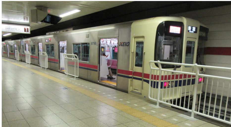
転落防止固定柵設置例(京王八王子駅)
