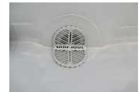
【上：排水部の防水改修前、下：ルーフドレン更生工法(横型)による防水改修後】
