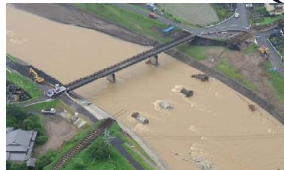
■ 久大本線 光岡～日田間 花月川橋りょう流出
