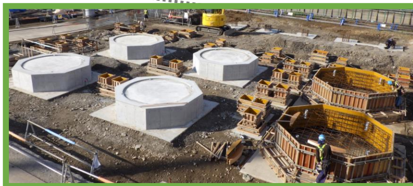
建設現場の様子
