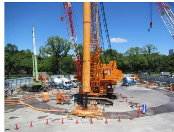
名城非常口 (地中連続壁工)
