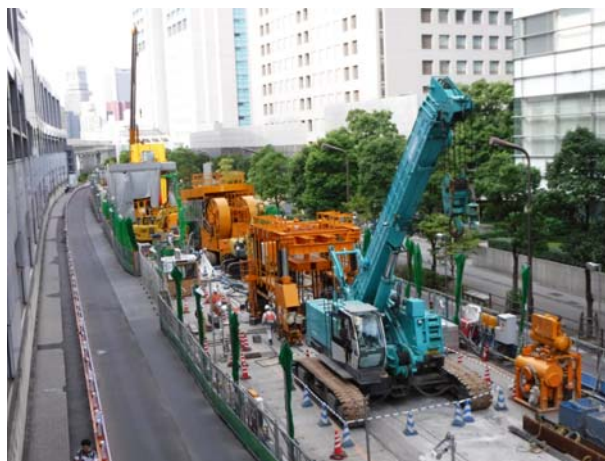
品川駅 (地下駅の地中連続壁工)
