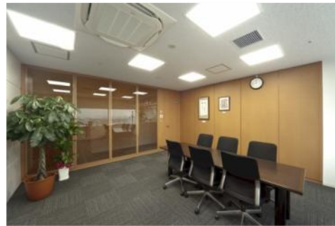
LED照明を設置し、床を張り替えたフロア
