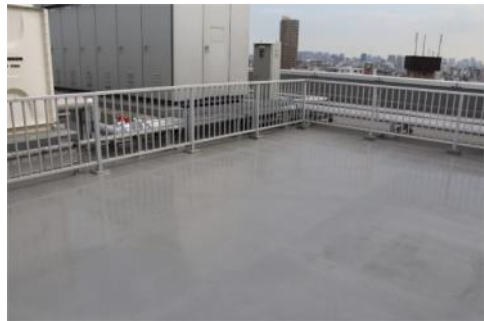
防水工事を行った屋上フロア
