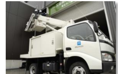
修理・保守点検の様子
