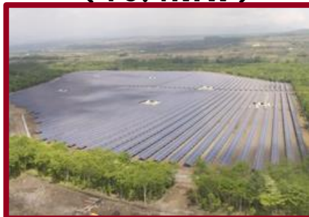
9月:群馬県 孺恋SW (15.4MW)
