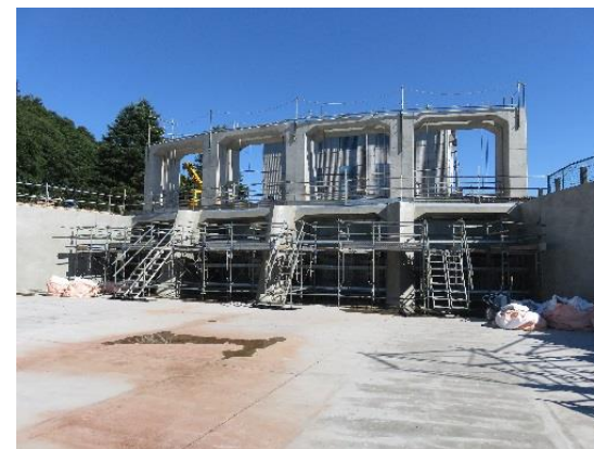
更新工事中の広桃発電所
