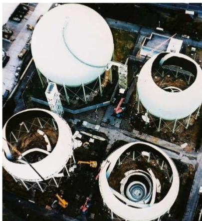
ガスホルダー（リンゴ皮むき工法）
