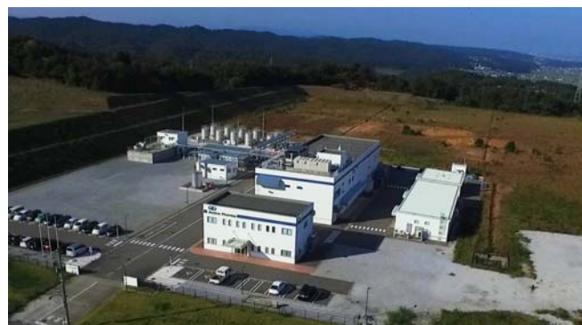
富山八尾工場敷地（現状）
