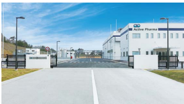
富山八尾工場外観（現状）
