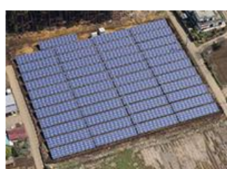
S-03 LS千葉若葉区発電所
