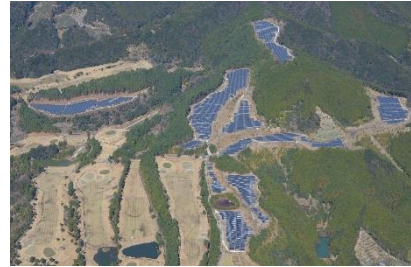
LS白浜発電所 パネル出力：7,839.72kw
