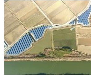
S-18 LS稲敷荒沼2発電所
