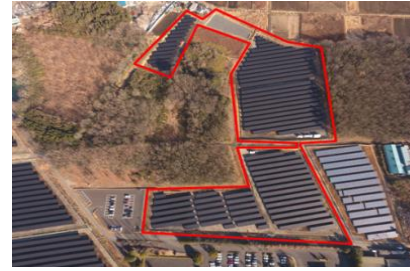
LS桜川1発電所 パネル出力：2,545.92kw
