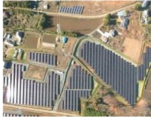
S-19 LS桜川下泉発電所
