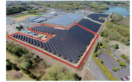
LS桜川3発電所 パネル出力：2,464.32kw
