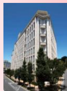
御殿山SHビル
