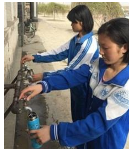
河北省围场県先任学校での水道供給設備建設
