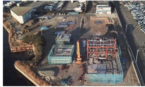
※建設中の横須賀バイオマスエナジー
