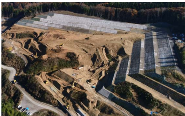
※建設中の新最終処分場
