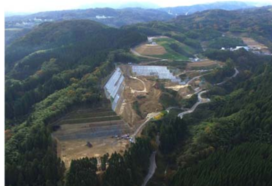
北陸環境サービス新最終処分場(建設中)
