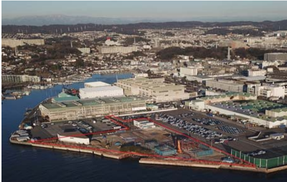
横須賀バイオマスエネジー(建設中)
