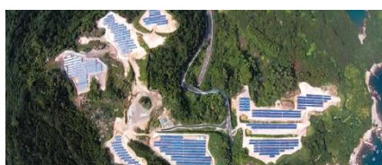
S-03 東洋町メガソーラー発電所
