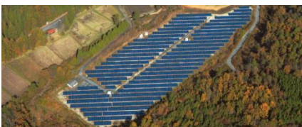
S-07 岡山高梁太陽光発電所
