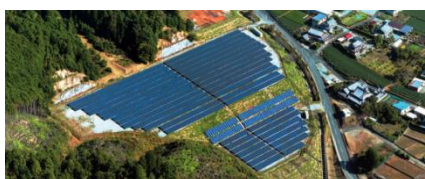
S-05 松阪市飯高町太陽光発電所(南北)
