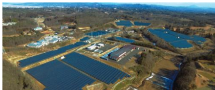
S-01 一関市金沢太陽光発電所
