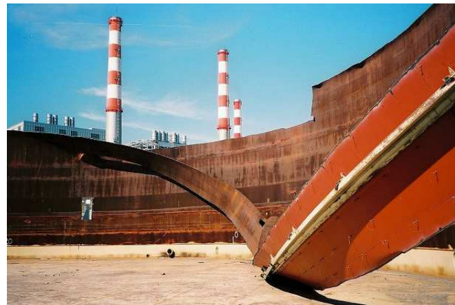
火力発電所（リンゴ皮むき工法）
