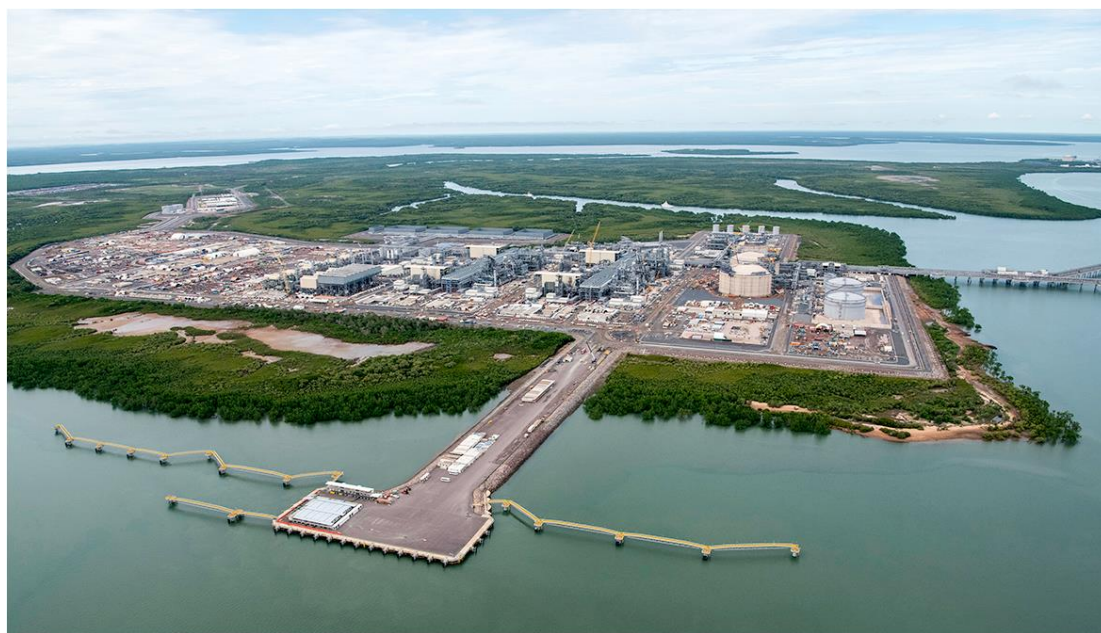
陸上ガス液化プラントの様子
