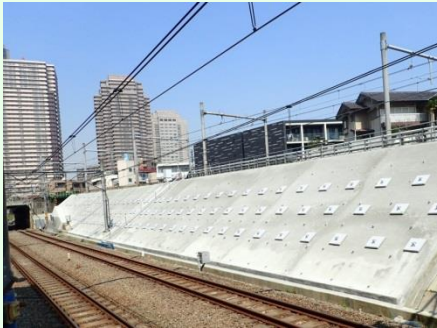
耐震補強対策
